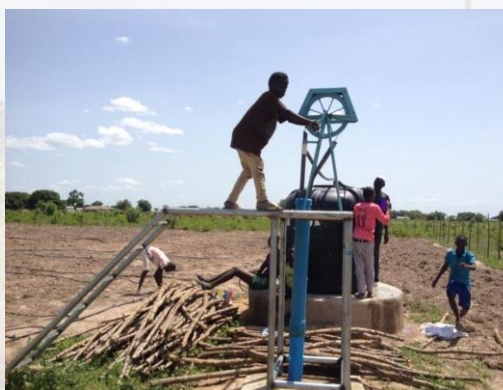
Aanleg van druppelirrigatie-tuin met put, touwpomp, opslag tank en druppelirrigatie-slangen
