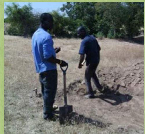
De eerste swale wordt aangelegd door twee medewerkers
